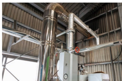
配管のみの安価な改造で供給能力を確保
